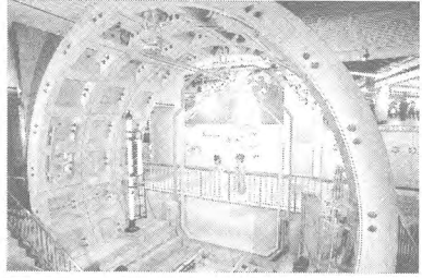
地下鉄シールドトンネル
