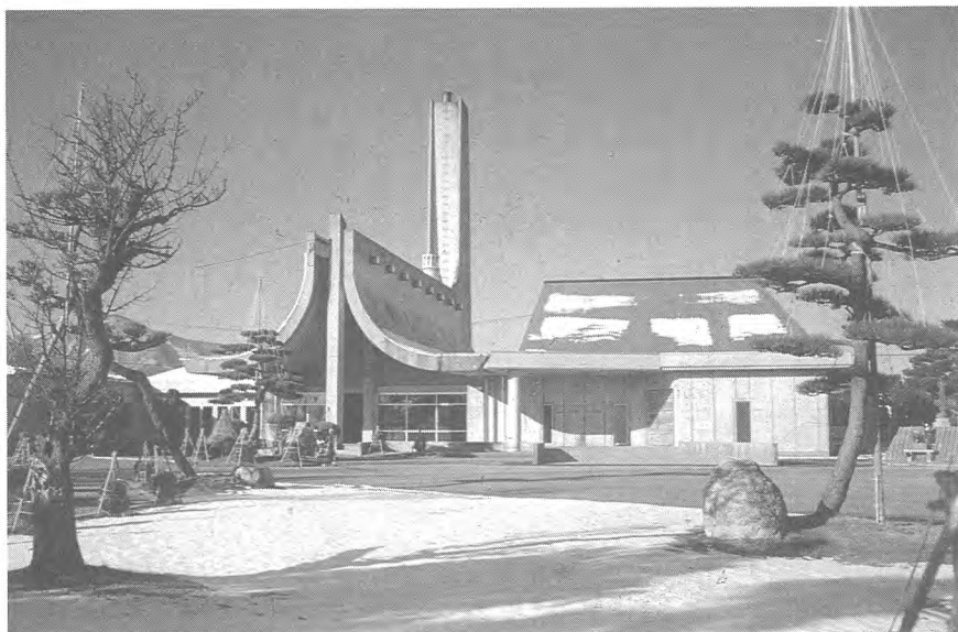
妙有院（新潟県巻町ほか組立火葬場） 左（1968年の建築）煙突を建築デザインの中に取り入れた。右（1988年の増築）火葬炉の改善で排気筒処理により煙突が見えない。
